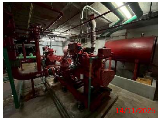
รูปที่ 2-31 ป้อนน้ำดับเพลิง
